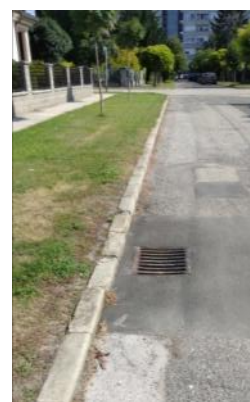
Vág utca (zárt szelvény, az útfelület repedezett)
